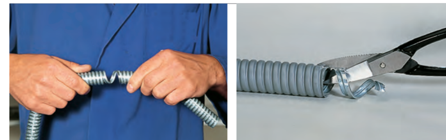
Metallschlauch kräftig nach innen verjüngend aufdrehen (eine Hand nach rechts, andere Hand nach links drehen)
