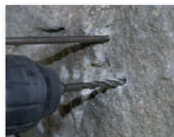
Perçage en vitesse lente
